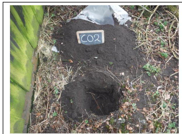
Foto 2. Asbestinspectiegat C02
