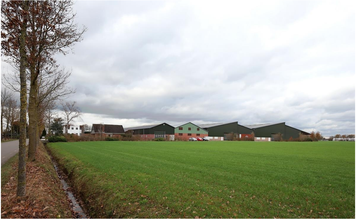
Impressie van de situatie enkele jaren na afronding van de inrichtingsmaatregelen.
