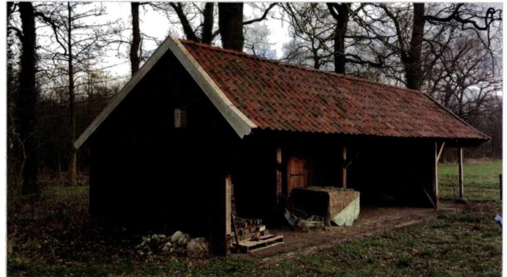
Foto: Bestaande te behouden kapschuur aan de overzijde van de weg.
