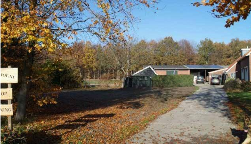
Afbeelding: Bestaande toegang tot woonhuis
