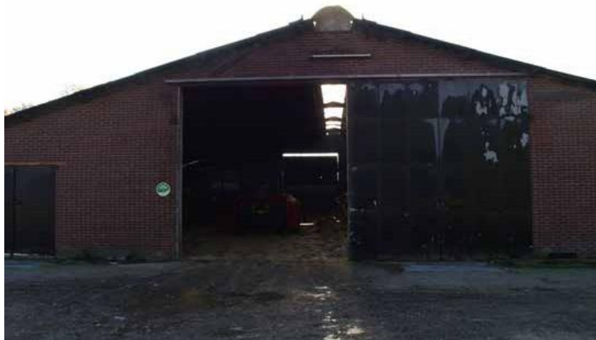
Afbeelding: Te slopen stal
