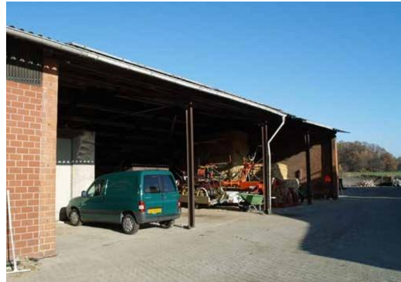
Afbeelding: Te slopen deel van de bestaande schuur bevindt zich aan de rechterzijde van de regenpijp
