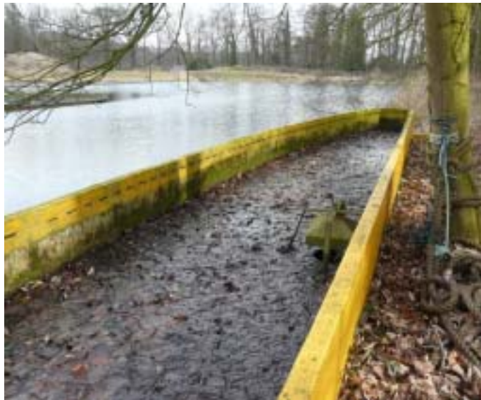
Afb.57 Het betonnen reservoir van de cascade.
