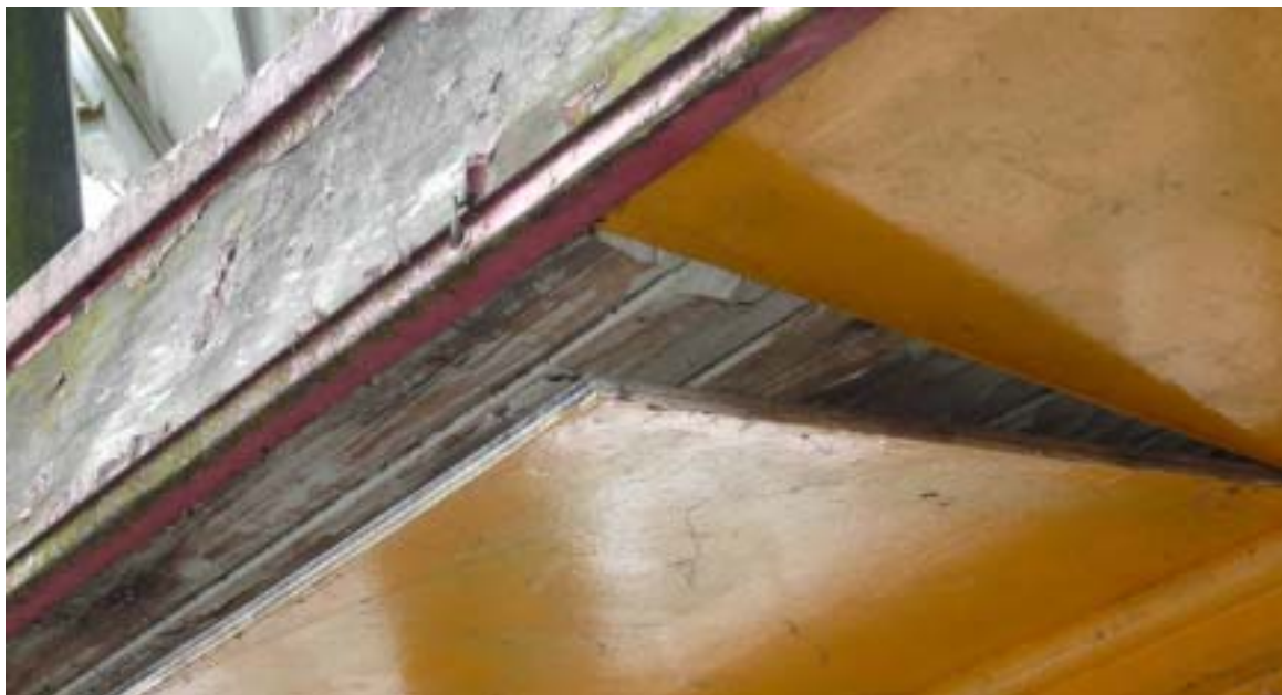
Afb.54 Het dakoverstek van het badmeestershuisje. De oorspronkelijke betimmering met vellingschroten is zichtbaar.
