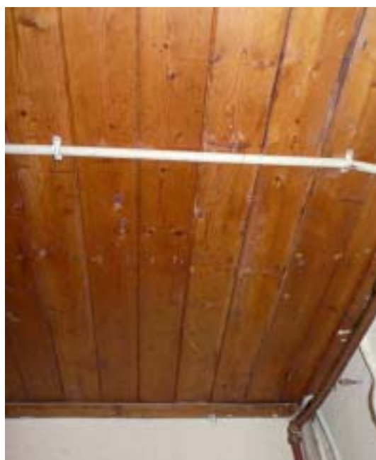
Afb.34 Het schrotenplafond ter plaatse van de de kantoortjes naast de trap.
