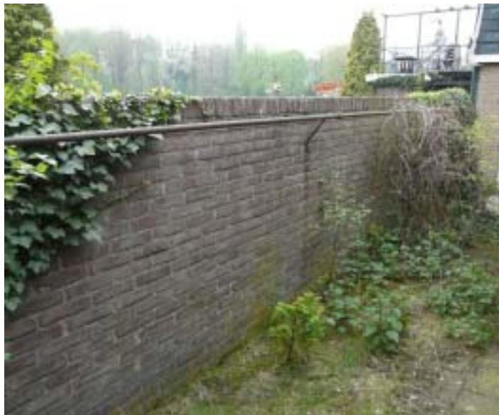
Afb.47 De muur, voorlangs de badhokjes, aan de badzijde van de linker zijvleugel. De muur is voorzien van een originele leuning. Voor de muur bevindt zich nog de spoelgoot.
