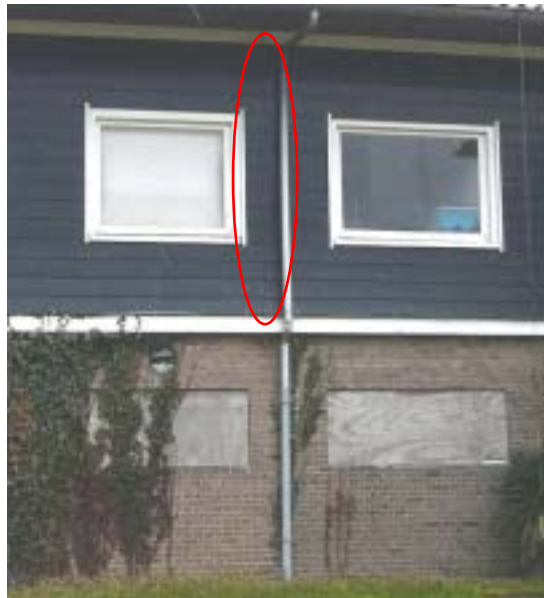
Afb.20 Naad tussen het oorspronkelijke gebouw uit 1933 en de uitbreiding uit 1954.
