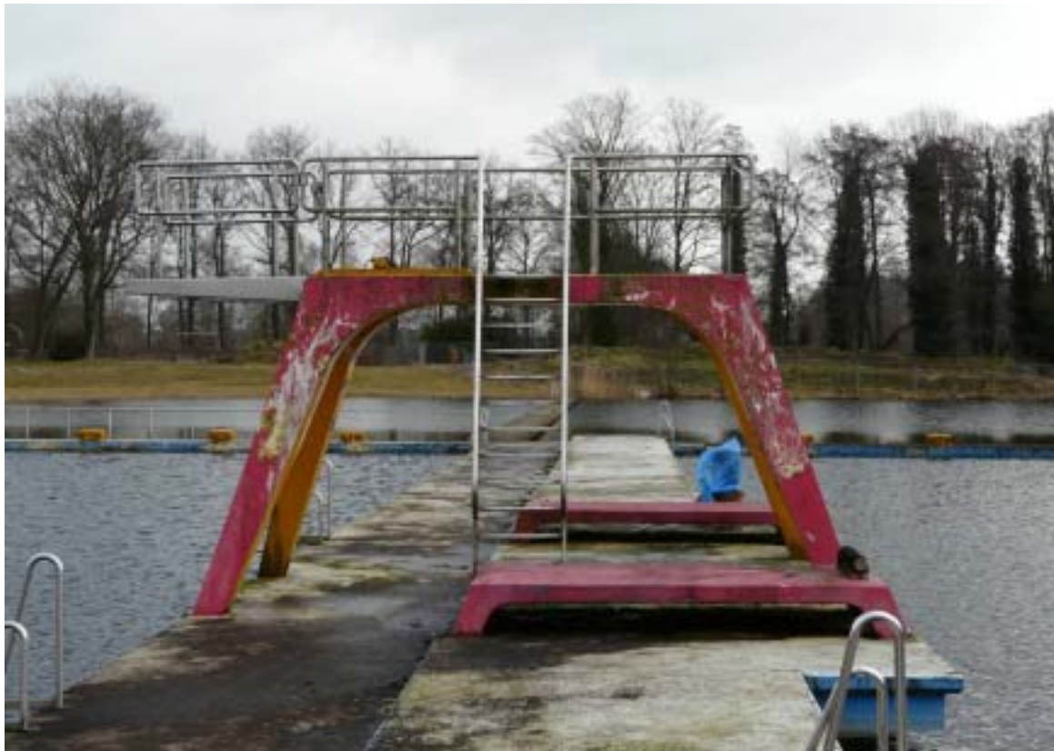
Afb.51 De betonnen duiktoren.
