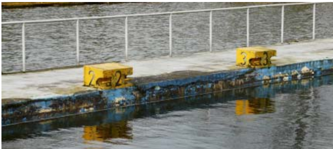
Afb.52 De betonnen startblokken.
