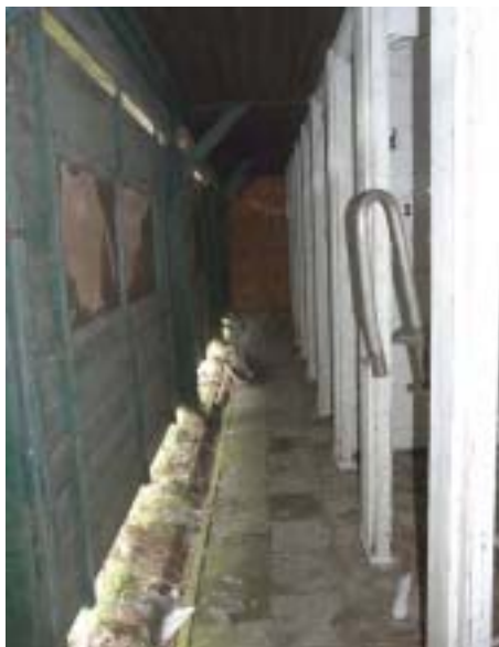
Afb.46 De gang die is ontstaan nadat in 1954 een nieuwe rij badhokjes (rechts op foto) is geplaatst in de voormalige rijwielstalling. Links langs de gevel zien we de spoelgoot.
