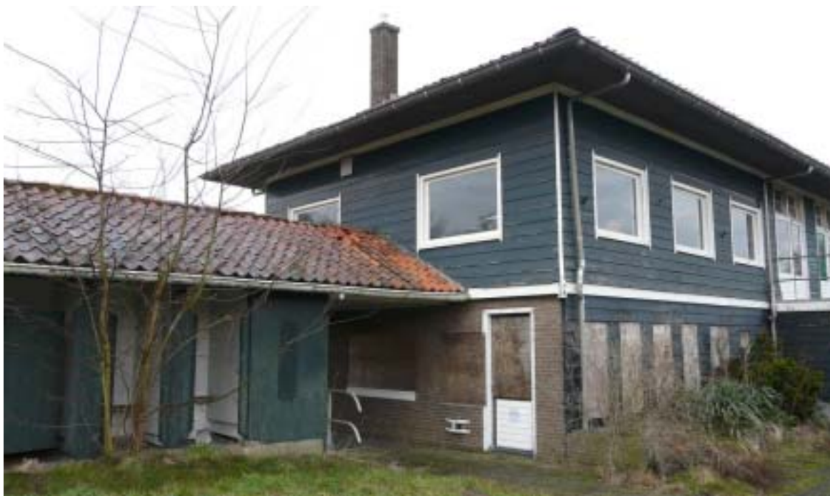
Afb.30 De rechter kopgevel van het hoofdvolume.
