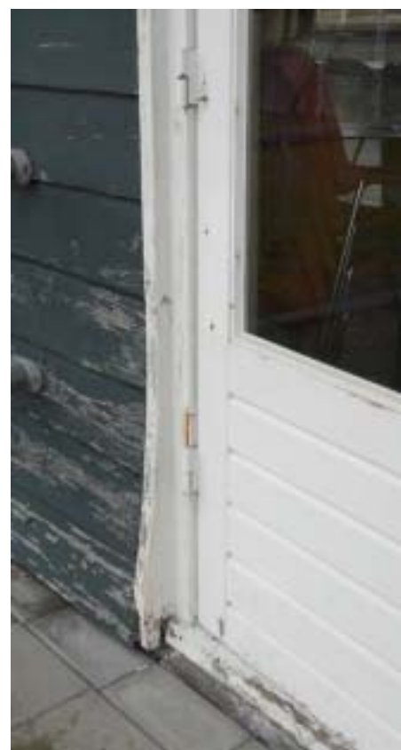
Afb.26 Detail ter plaatse van de linker balkondeur.
