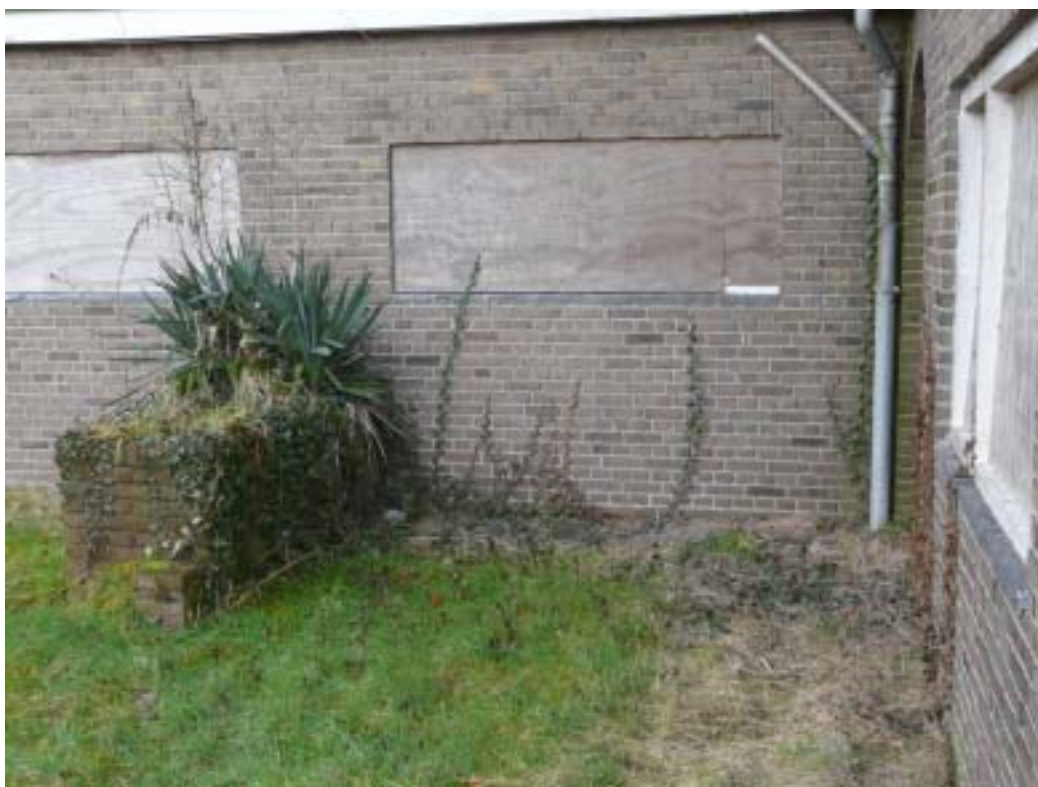
De bloembak aan de linker zijde met een restant van het bordes. Rechts is de rondboogvormige toegang zichtbaar.
