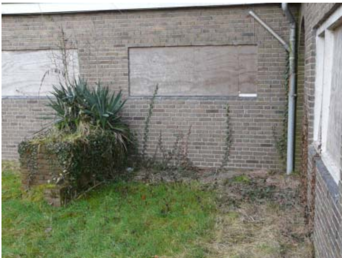
Afb.23 De bloembak aan de linker zijde met een restant van het bordes. Rechts is de rondboogvormige toegang zichtbaar.
