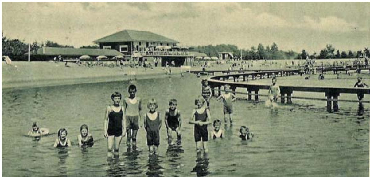
Afb.5 Het paviljoen van het Strandbad, zoals het er tussen 1933 en 1954 uitzag vanaf de zijde van het bad. (Bron: www.strandbad.nl )
