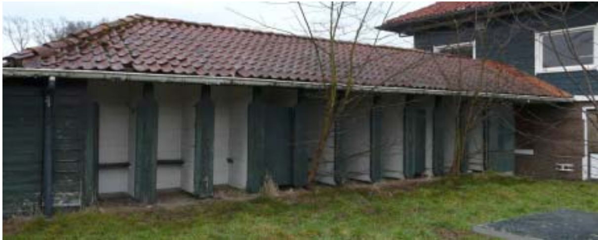
Afb.43 De badhokjes ter plaatse van de rechter zijvleugel.
