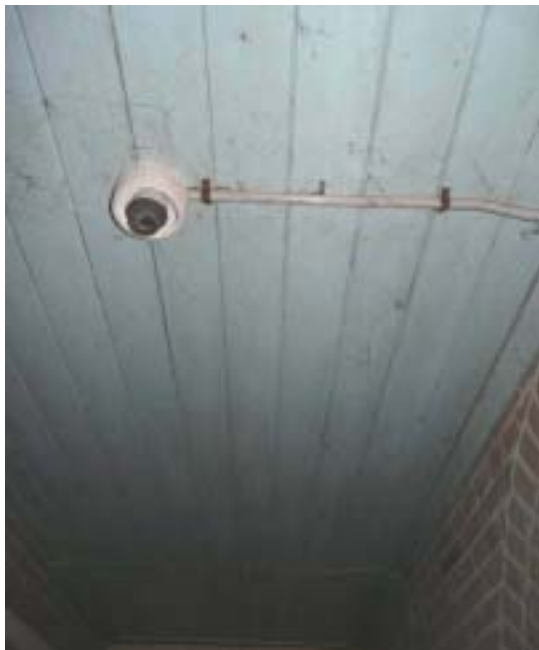
Afb.33 Het schrotenplafond ter plaatse van de gang.
