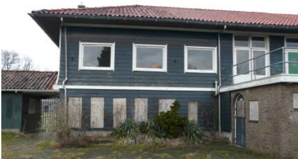
Afb.29 Het linker gedeelte van de achtergevel.
