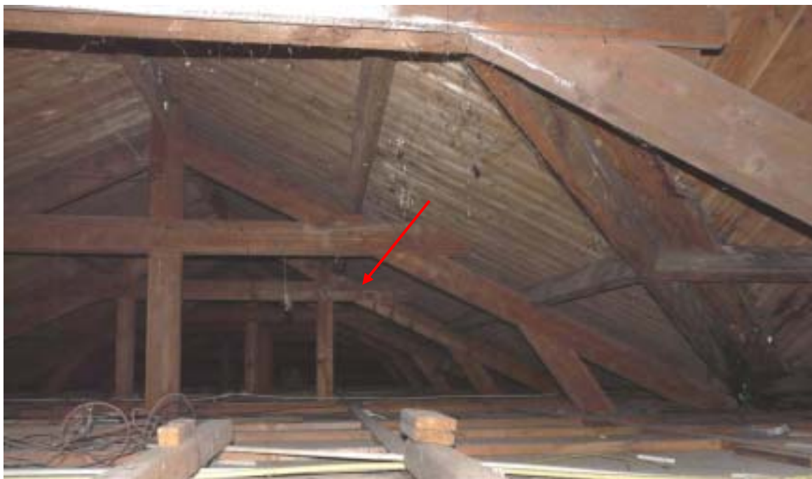
Afb.31 De kapconstructie. De rode pijl markeert het buitenste spant van het oorspronkelijke bouwvolume uit 1933.
