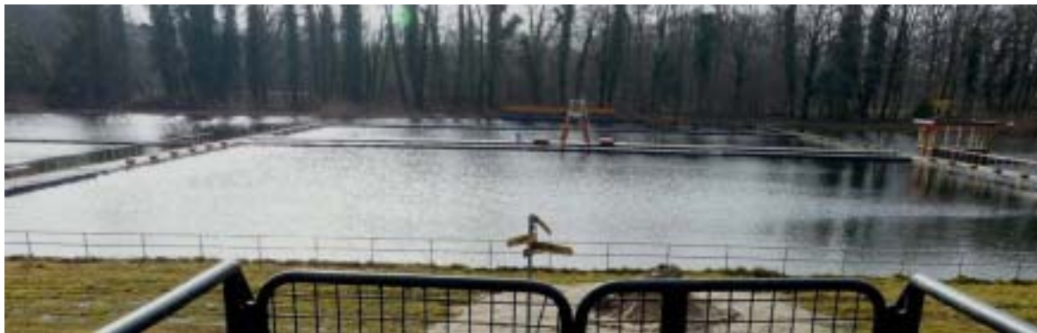
Afb.49 Het bad gezien vanaf het balkon van het paviljoen.
