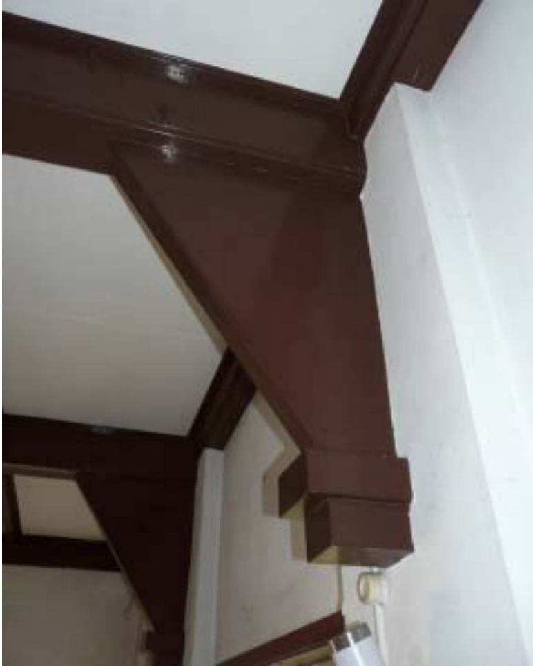
Afb.38 De spantbenen steken door het plafond naar beneden en worden door middel van een console opgevangen. Het geheel vormt tevens een decoratief element.
