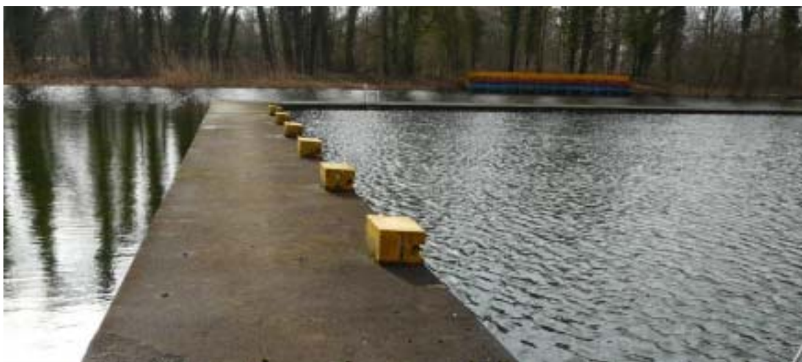
Afb.50 De betonnen steigers met startblokken.
