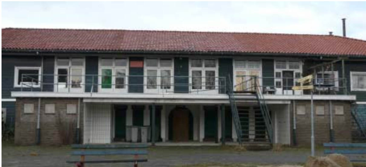
Afb.24 Het balkon aan de achterzijde met hieronder de toiletgroepen, enkele badhokjes en de rondboogvormige toegang tot de middengang.
