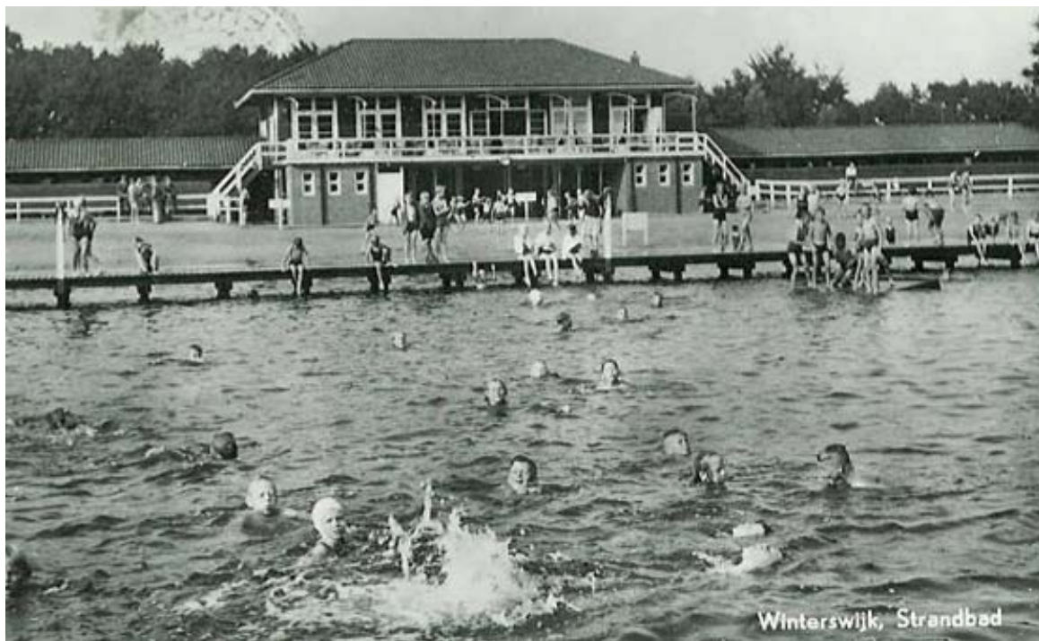
Afb.27 De achterzijde van het paviljoen vóór 1954. (Bron: www.strandbad.nl )
