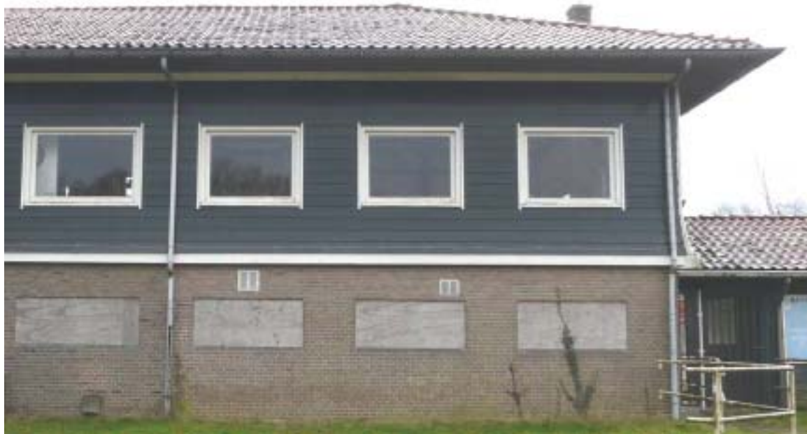
Afb.28 Het rechter deel van de voorgevel van het hoofdvolume: op de begane grond de (met plaat dichtgezette) tweeruits vensters en op de verdieping de schuifvensters.
